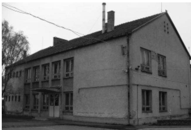
Nyáron kezdődik a leendő egészségház felújítása
