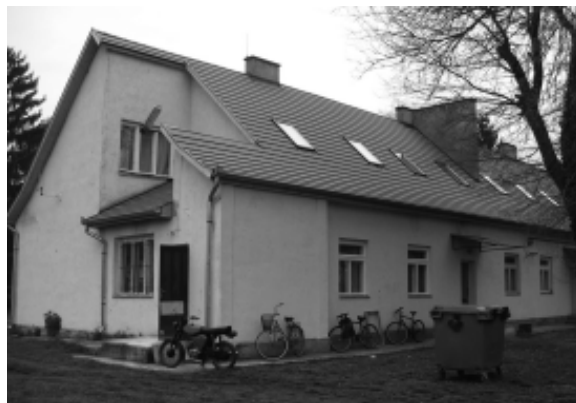
Kívülről már megszépült, a belső munkálatok pedig hamarosan befejeződnek a kiskoliban
